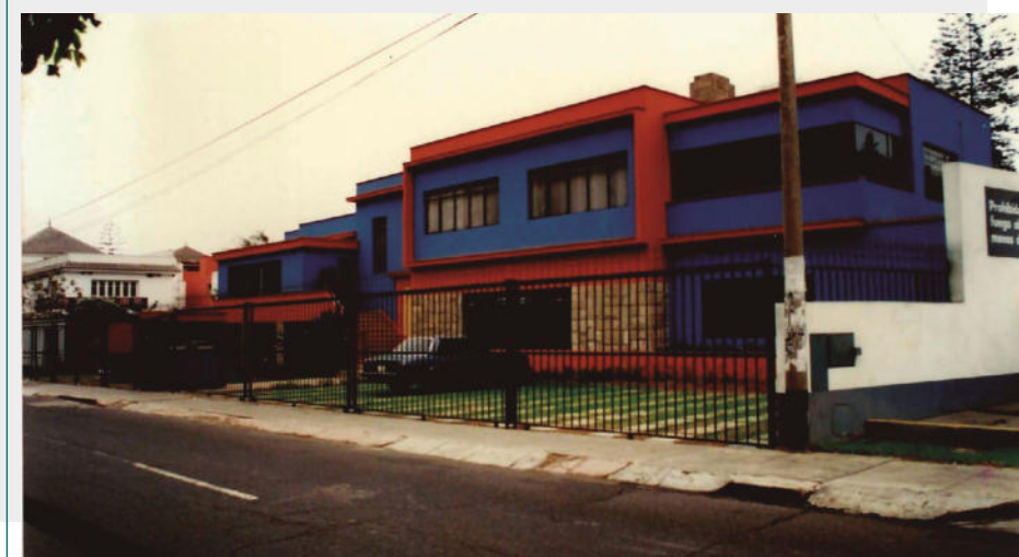
Fotografía del local de la Academia de la Magistratura en la avenida Gregorio Escobedo 426, Jesús María. En este local funcionaría la AMAG a partir de la segunda mitad del año 1997 hasta setiembre de 2002, antes de trasladarse a su local actual en el jirón Camaná 669, en el Cercado de Lima.
